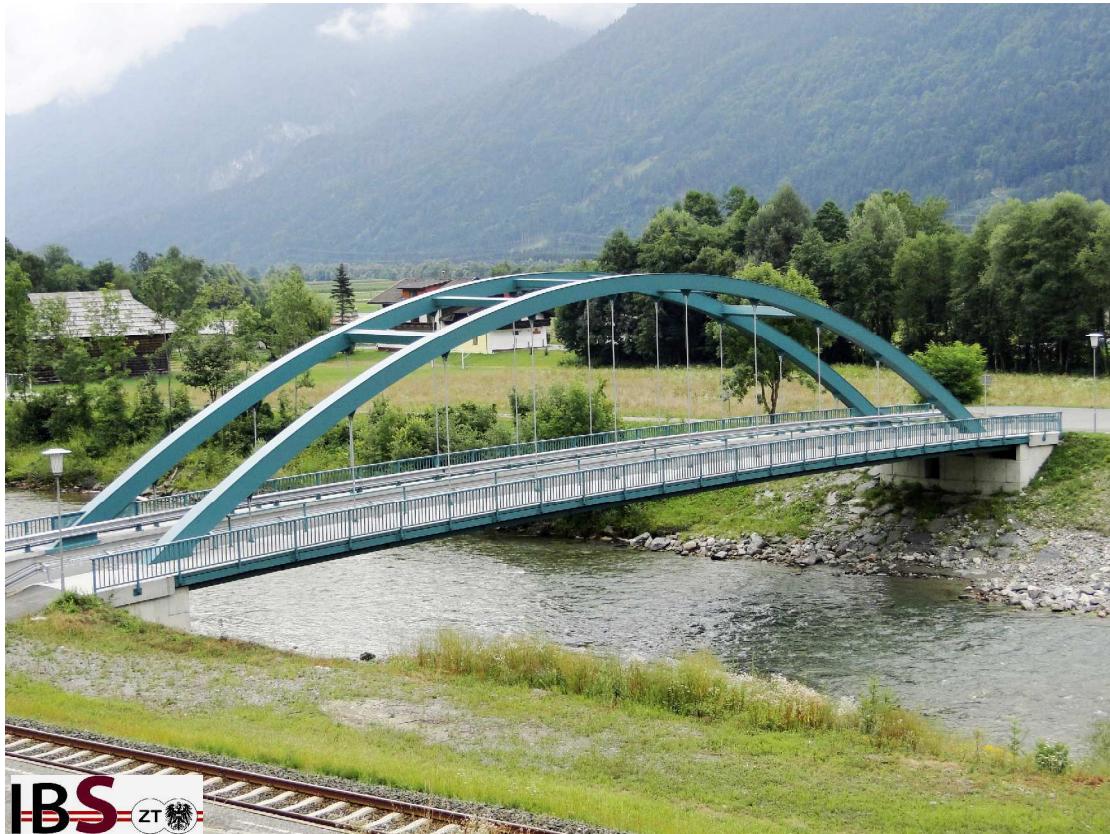
P1) Foto 01: S180-08: Stahlbogenbrücke Watschig über die Gail (L= 52,5 m)
