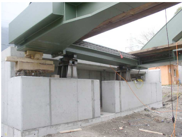
P1) Foto 02 a: Stahlkonstruktion mit Endquerträger und Kämpfer
