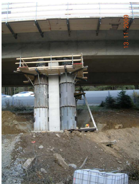
P6) Foto 12 a: Brückenanhebung für Lagertausch
