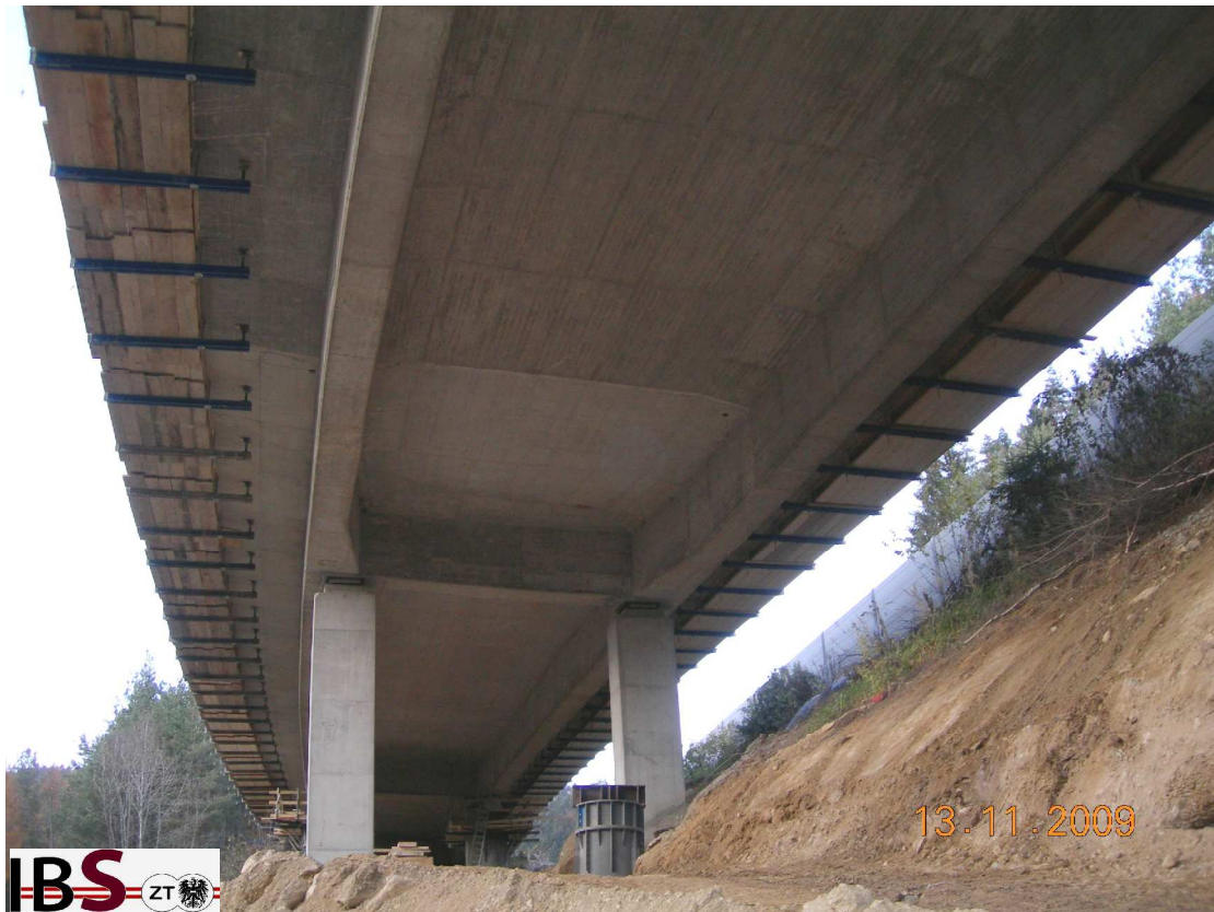
P6) Foto 12 a: Brückenanhebung für Lagertausch
