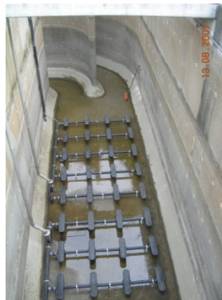
Bodenplatte der Belebungs-
