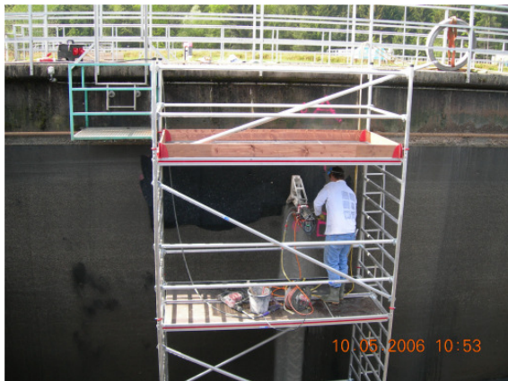
BB-II: Bohrkernentnahme Südwand
