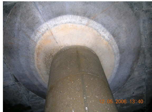
Optische und statische Prüfung der Mittelstütze
