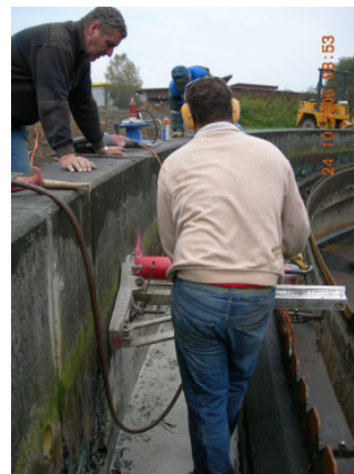
Entnahme von Bohrkerne
