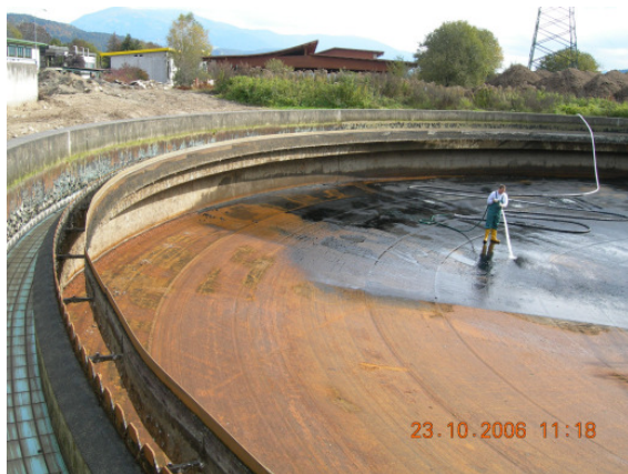
Reinigen der Bodenplatten
