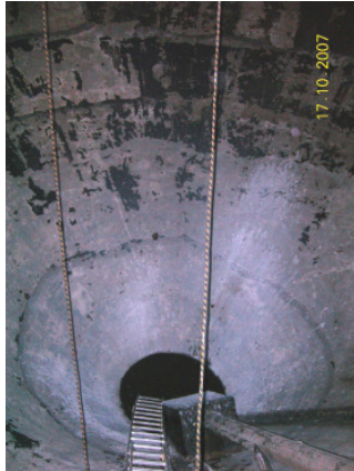
Prüfung des Behälterbodens
