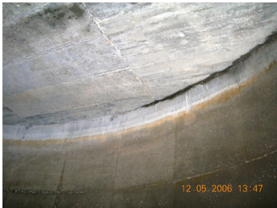
HB Radlach: Betonprüfung der Behälterdecke
