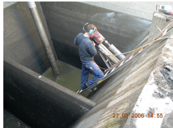
Entnahme von Bohrkerne im Pumpensumpf der Vorklärbecken
