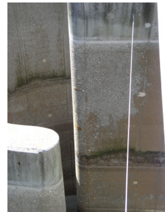
Trennwand im Bereich Strahlumlenkung
