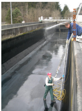
Reinigung des Vorklärbeckens Nord
