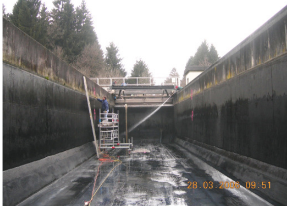
Vorklärbecken Süd im entleerten Zustand
