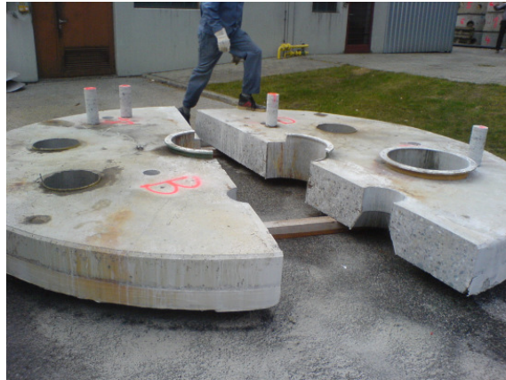
Bohrkernentnahme der Behälterabdeckung
