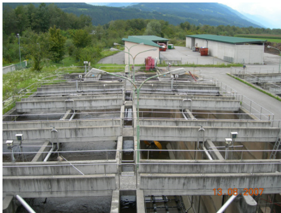
Übersicht der Belebungsbecken Nord/Süd
