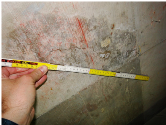
Wasseraustritte aus der Bodenplatte und Aussinterungen
