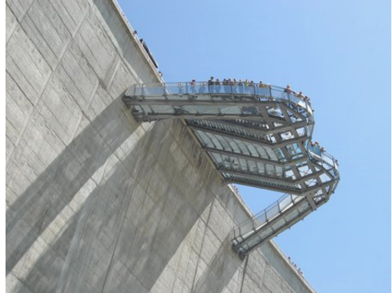
Untersicht der Konstruktion
