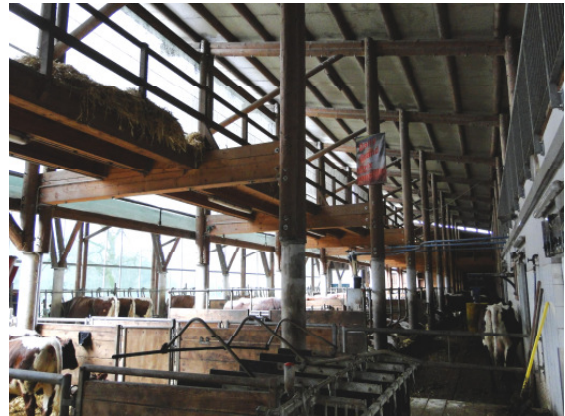
Anschluss der Hauptträger an die Stützen
