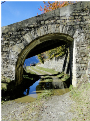
Bestehende Unterführung zum Pumpwerk Hattelberg (Ansicht von West)
