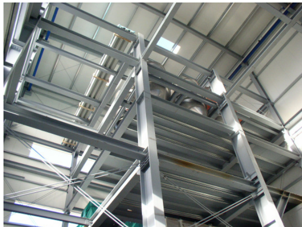
Stahlkonstruktion im Gebäudeinneren
