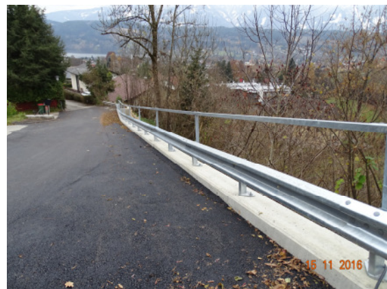
Fertiggestellte Stützkonstruktion
