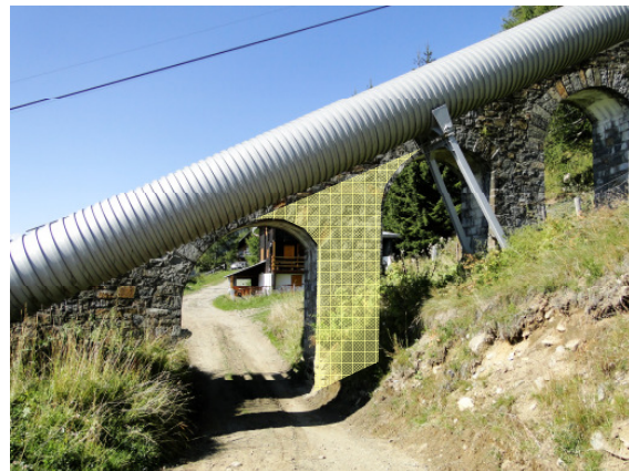
Aufweitung der Unterführung Floridsdorf (Ansicht von Ost)
