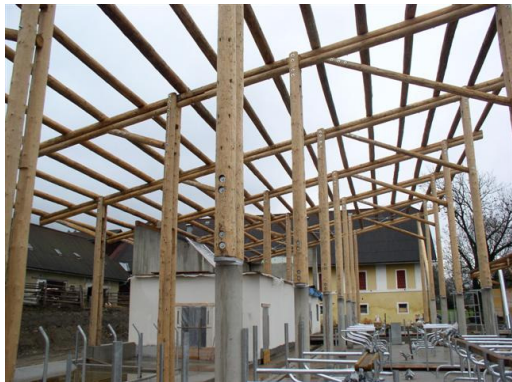
Bauzustand der Tragkonstruktion
