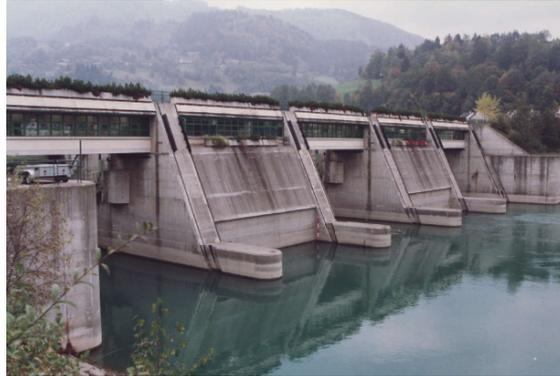
Foto b) Großausführung (seitliche Tosbeckenwände waren nicht erforderlich)
